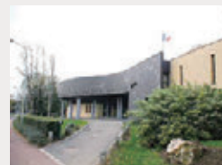
エコール・セントラル
