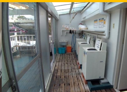
ランドリー(改装中) Coin laundry (Under renovation)
