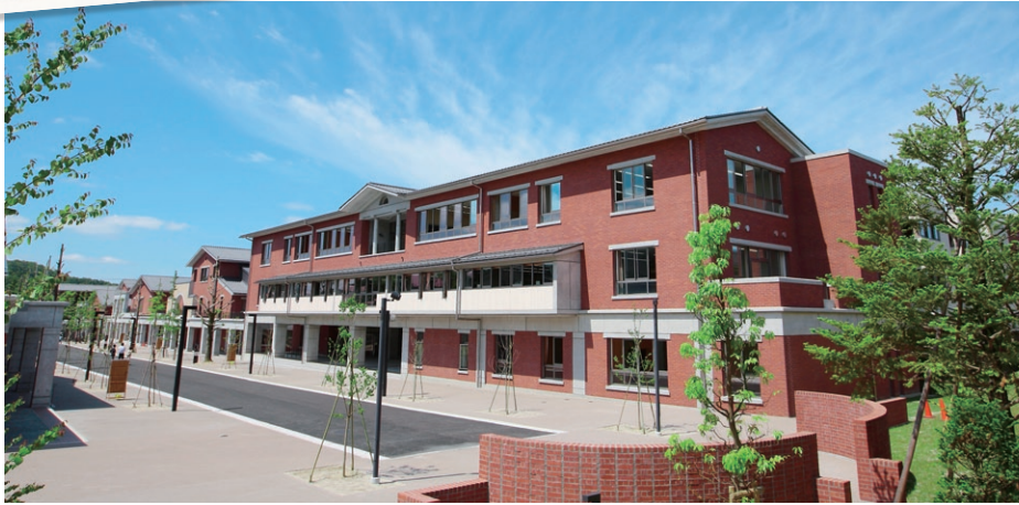
竣工日2010年3月3日
