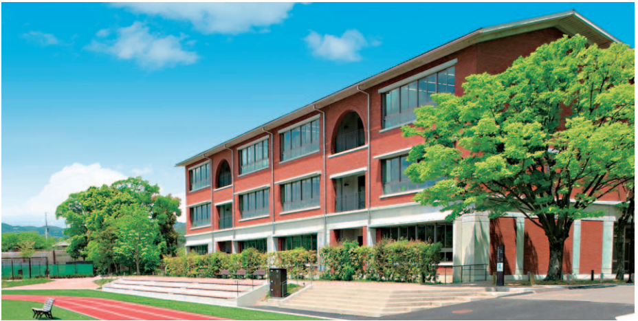
竣工日 2008年11月4日
