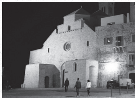
図10 モルフエッタの旧大聖堂 12世紀半ばに着工。内部空間も素晴らしいロマネスク様式。ファサードはすぐそばの港に向いている
