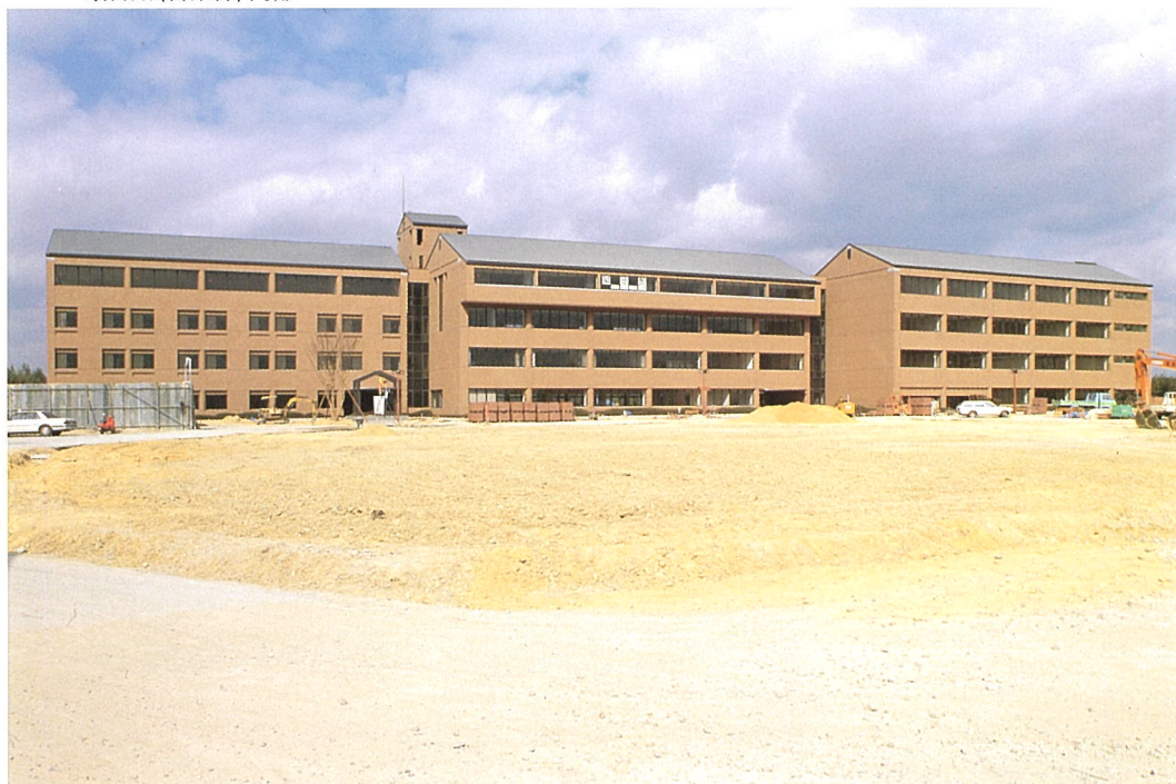
知徳館 (管理研究室棟・講義・演習棟)
