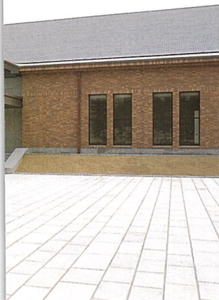
副業館(事務管理棟)
