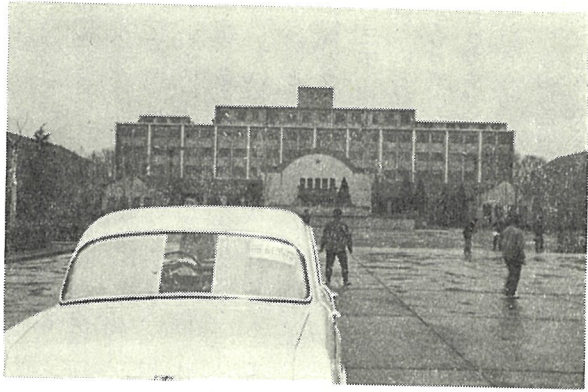
西北大学本館玄関から中央広場を望む。野外集会場の後は新校舎
