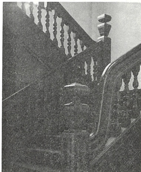
理化学館内部の階段
