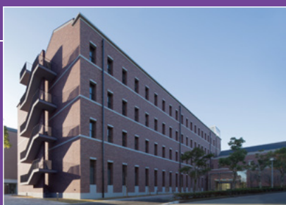
2014年 訪知館 竣工
