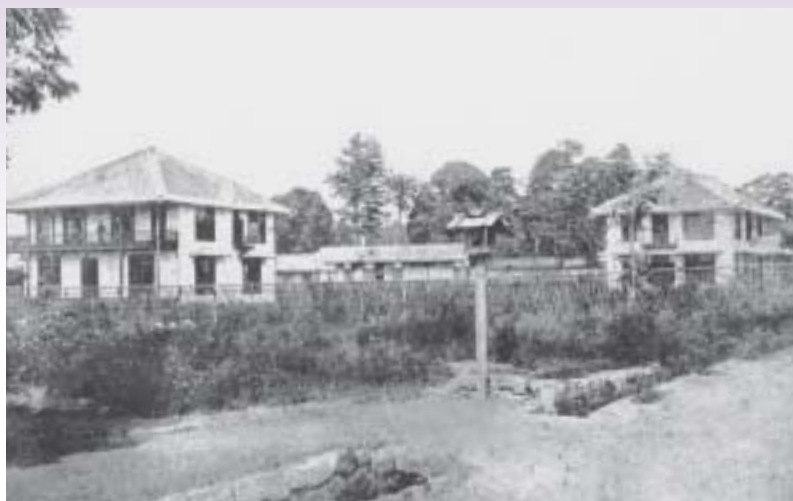
第一寮(右)と第二寮(左)。中間は食堂。
