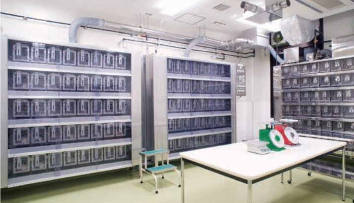
一方向気流式飼育システム 最大160匹のラットが飼育可能な自動給水・洗浄ラックを導入しています。
