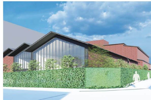
2023年5月竣工予定の育真館の外観イメージ(北東交差点より) ※法規・景観協議により変更の可能性があります
