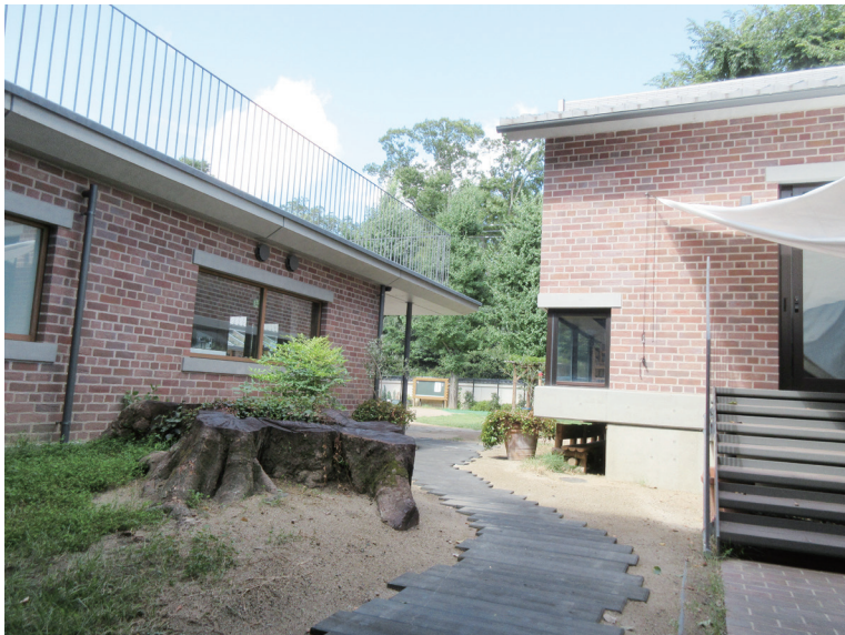
2023年8月完成 中庭の遊歩道
